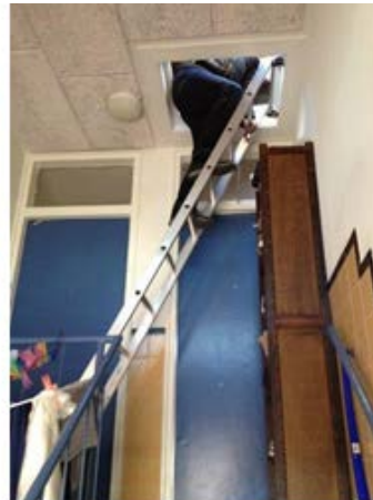
Toegang tot het dak
