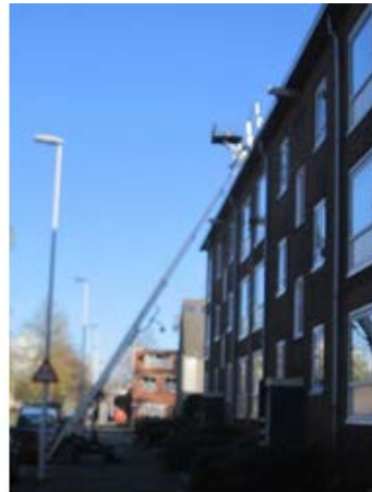
Gevel met dak overstek
