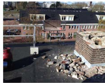
Deels gesloopte schoorsteen
