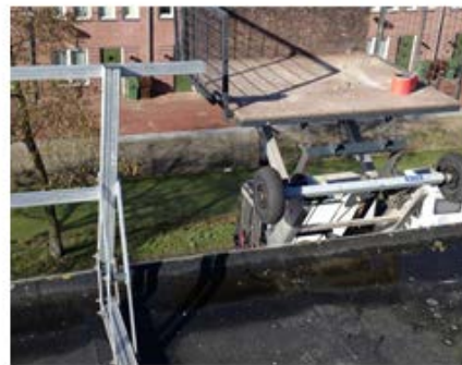
Aansluiting dakrandbeveiliging op ladderlift
